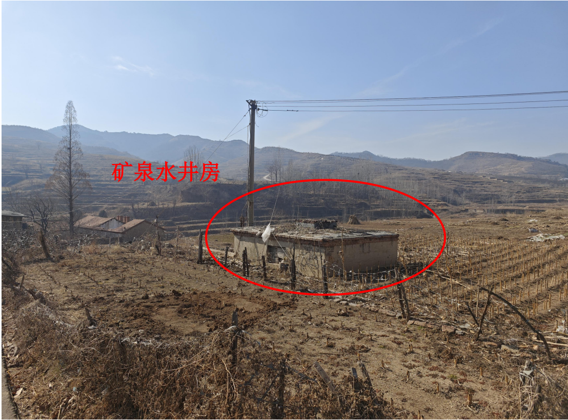
照片 3-1 矿泉水井房及附近现状
